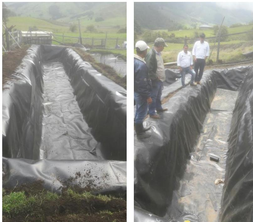
Ilustración : estanques con geomembrana instalada.
